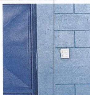
Foto 8: SUSTITUCION DE INTERRUPTORES DOBLES
