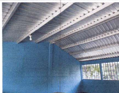
Foto 4: SUSTITUCION DE ESTRUCTURA DE METAL, POR METAL
