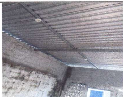
Foto 3: SUSTITUCION DE ESTRUCTURA DE SOPORTE DE MADERA, POR METAL
