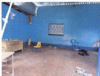
Foto 5: SUSTITUCION DE PISO DE CEMENTO LIQUIDO POR PISO CERAMICO
