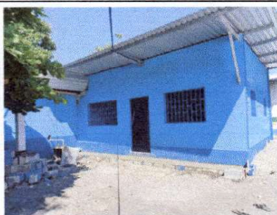
Foto1: SUSTITUCIÓN DE TECHO DE PALMA, POR LAMINA TROQUELADA ALUZINC CALIBRE 26
